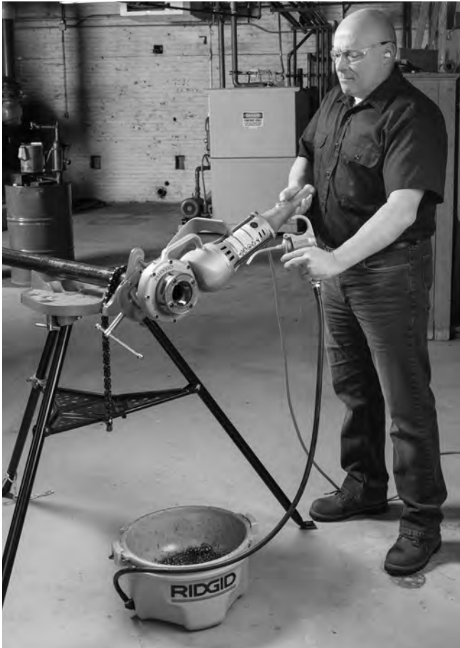
Abbildung 9 – Gewindeschneiden in Rohr
